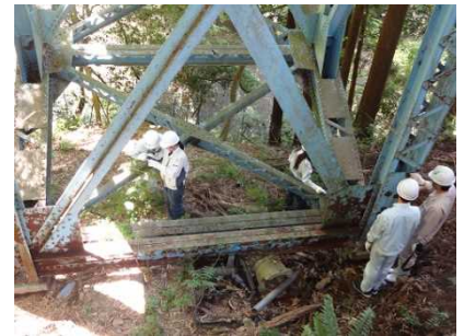
経年橋梁の現地調査
