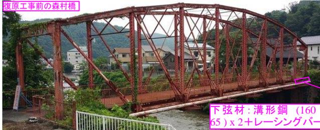
下弦材：溝形鋼 (160 x 65) x 2 + レーシングバー
