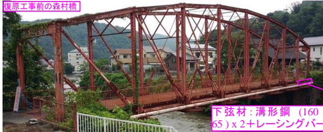
復原工事前の森村橋
