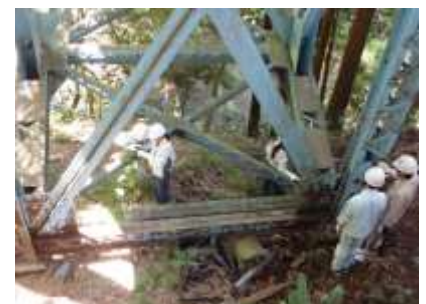
経年橋梁の現地調査
