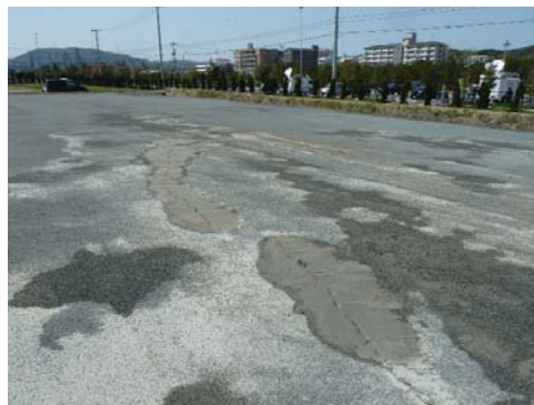
図 2 淡路市役所駐車場の噴砂跡
