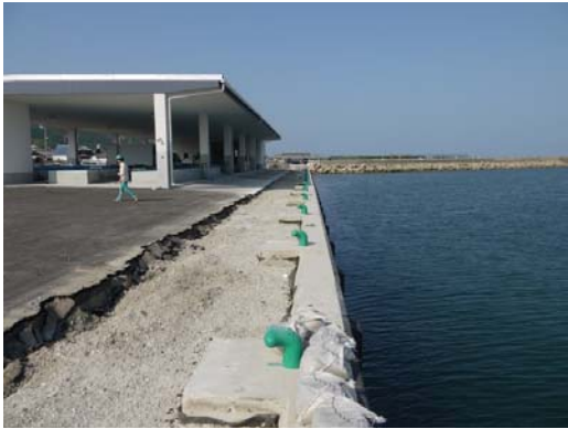
図 11 生穂漁港岸壁の移動
