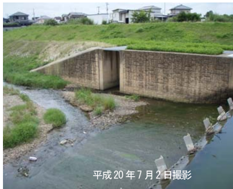
写真3 魚道下流側出入口（左岸から下流側）
