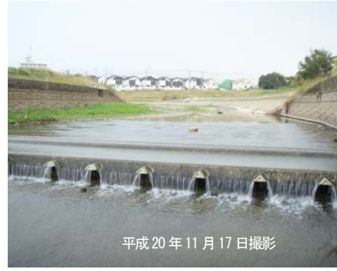
写真2 非貯留時の堰（堰下流側から上流側）
