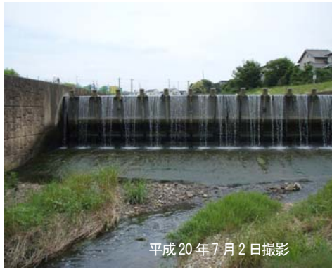
写真1 貯留時の堰（堰下流側から上流側）
