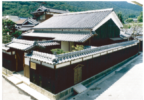
写真2 たつの市立武家屋敷資料館
