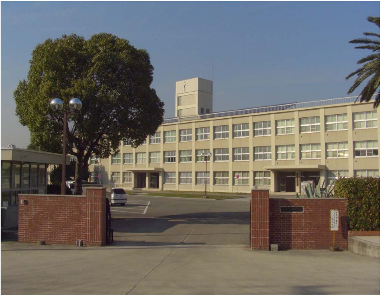
現況写真（正門付近の現況）
